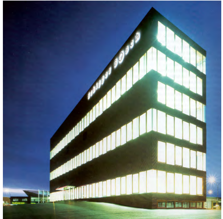
Hoofdmassa haaks op de weg geplaatst
